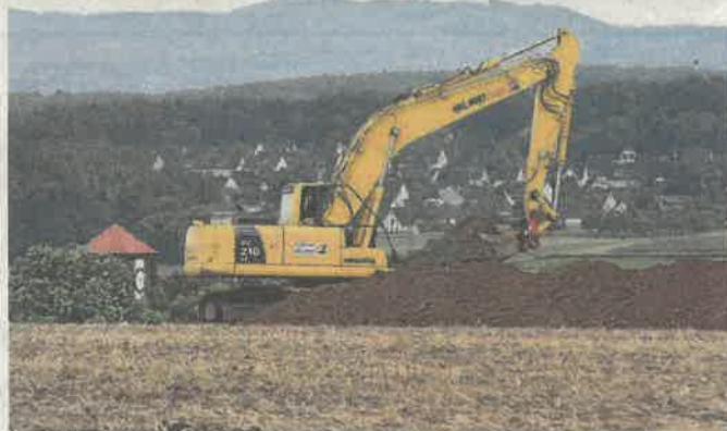
Der Bagger ebnet den Weg für die Archäologen, die sich derzeit auf der Suche nach eisenzeitlichen Funden schichtweise durch den Boden arbeiten.
