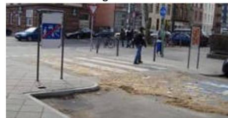
Abb. 135: "Gehwegnase" mit Aufpflasterung
