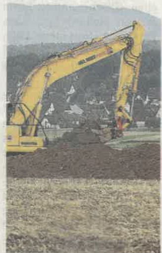
2015 rollten die Bagger schon einmal auf dem Schürenfeld. Damals allerdings wegen der archäologischen Funde.
