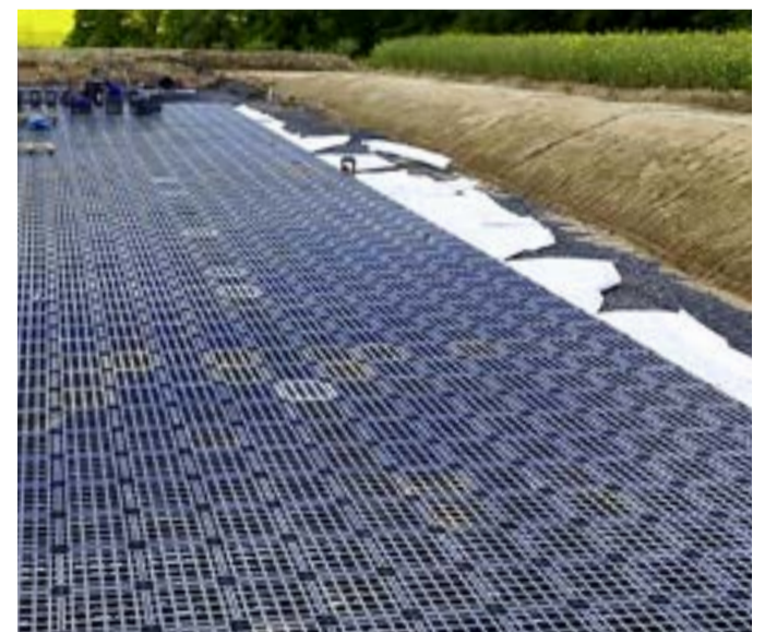
Das Besondere am Baugebiet: die Versickerungsanlage. Das Rigolensystem in der Versickerungsmulde sorgt dafür, dass Oberflächenwasser versickert und dem Grundwasser zugeleitet wird.
