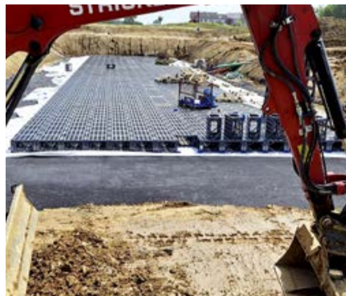
Das Besondere am Baugebiet: die Versickerungsanlage. Das Rigolensystem in der Versickerungsmulde sorgt dafür, dass Oberflächenwasser versickert und dem Grundwasser zugeleitet wird.
