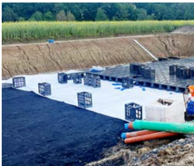
Das Besondere am Baugebiet: die Versickerungsanlage. Das Rigolensystem in der Versickerungsmulde sorgt dafür, dass Oberflächenwasser versickert und dem Grundwasser zugeleitet wird.
